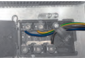
Schema allacciamento elettrico monofase (morsettiera)
